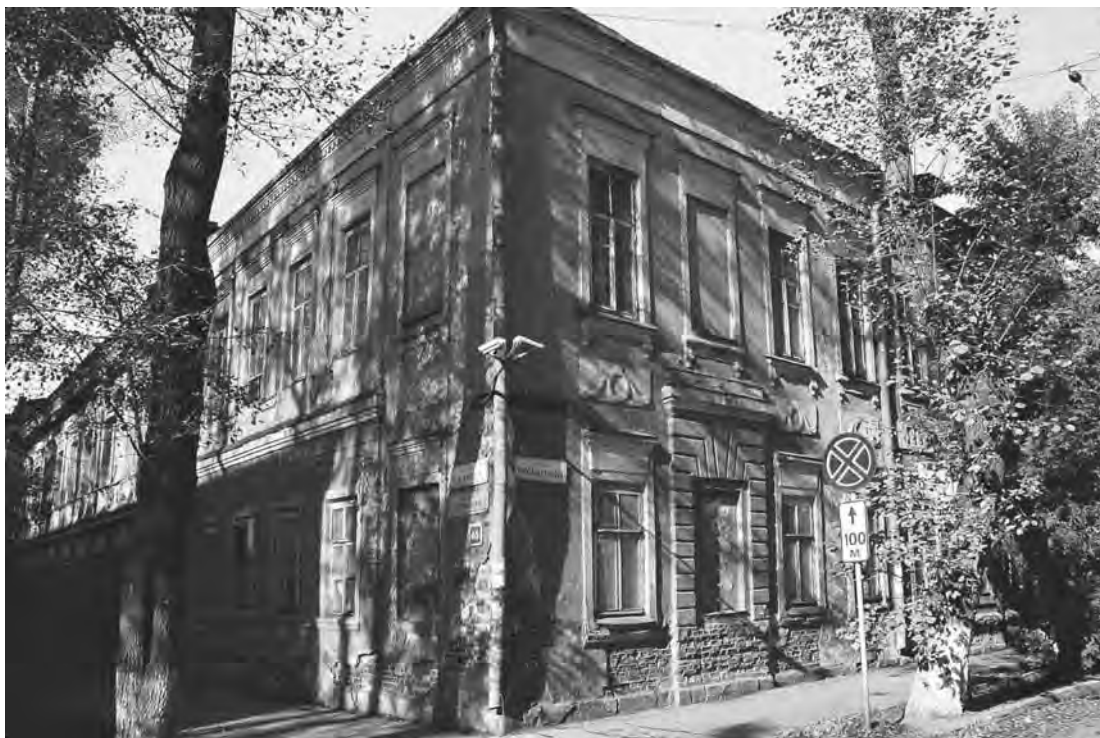
Особняк на перекрестке улиц 5-й армии и Я. Гашека
